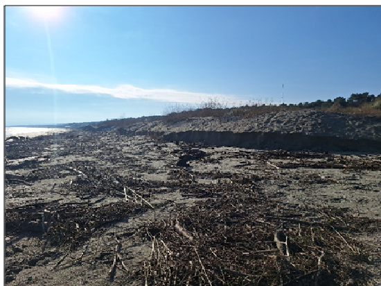
Figura 28: Panoramica e dettagli dell'erosione argine invernale e accumulo materiale vegetale nel Ravennate a Marina Romea, sud Foce Fiume Lamone (RA)
