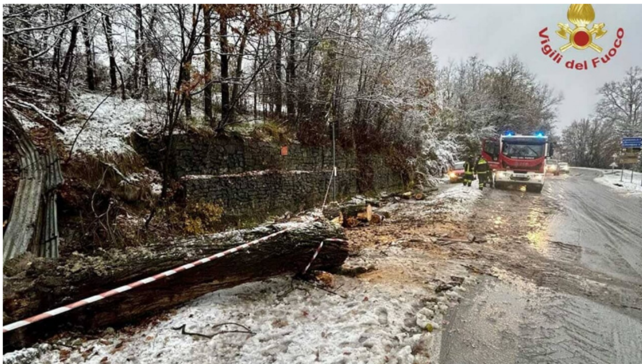
Figura 23: Danni causati dalla neve in provincia di Parma (fonte ParmaToday).
