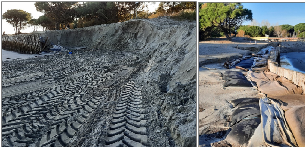
Figura 25: Panoramica danni della mareggiata nel Ferrarese a Lido di Volano – Bagno Isa con arretramento duna e danneggiamento opere di difesa
