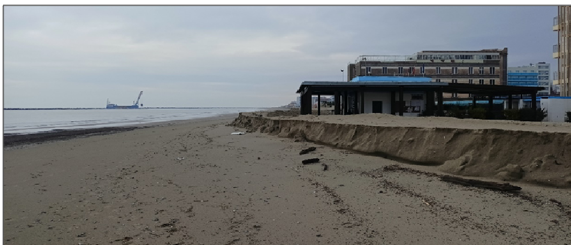
Figura 29: Erosione argine invernale nel Cesenate
