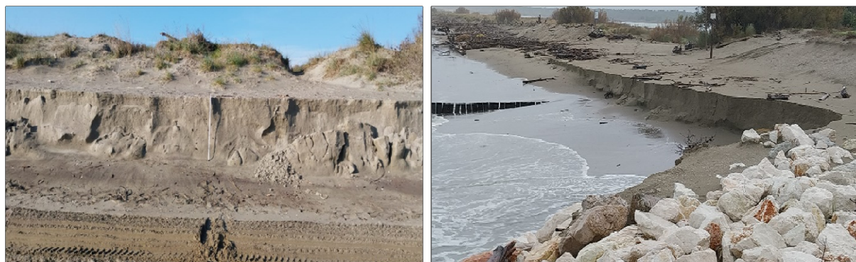
Figura 26: Danni della mareggiata nel Ferrarese: erosione Dune di San Giuseppe a Lido di Pomposa, (a sinistra) ed erosione arenile a Lido di Spina sud Bagno ex-Jamaica (a destra).
