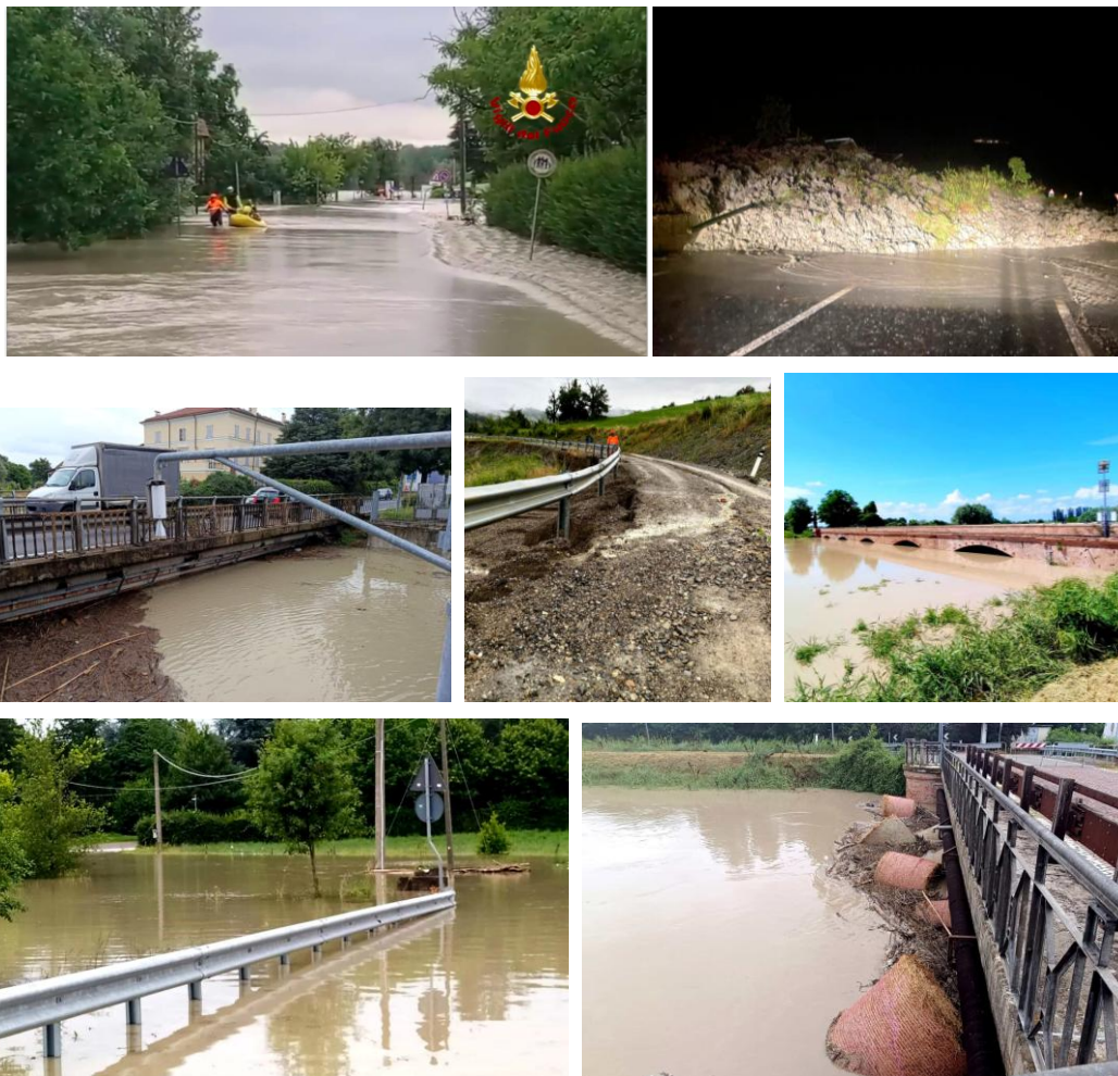
Figura 42: Allagamenti a Campogalliano nel Modenese, da un fotogramma, frana lungo la SP4, Fossalta, SP3, il Ponte Motta, Strada Santa liberata, Ponte Alto. Foto da Modena Today.
