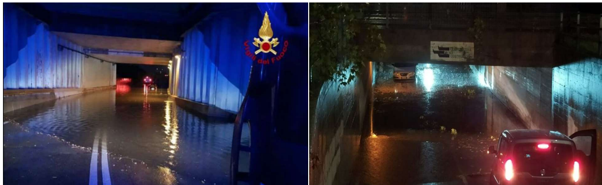
Figura 18: Allagamento di sottopasso a Bazzano a sinistra (fonte: Il Resto del Carlino). Allagamento di sottopasso a Modena (fonte: sito web ModenaToday) a destra.
