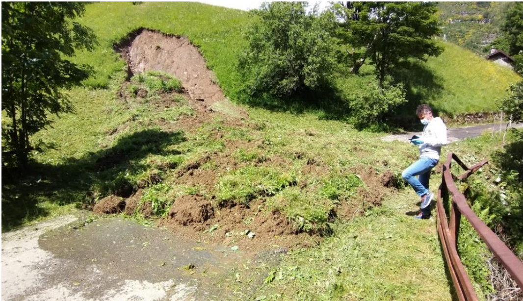
Figura 29: Modesto movimento franoso in località casa Baiocco (Fanano, MO) (foto ARSTePC).
