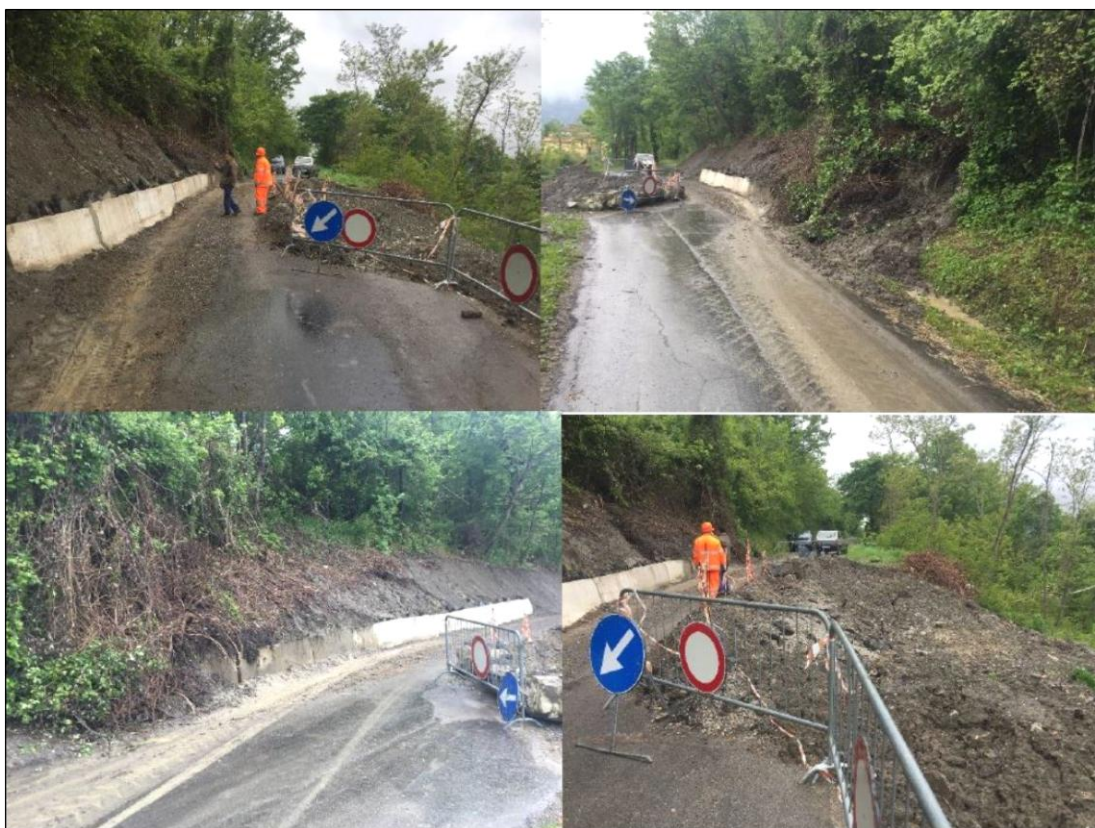
Figura 39: Alcune immagini del dissesto in via Rivabella (foto Comune Castel di Casio).
