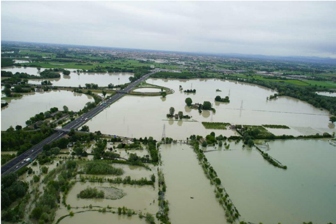
Figura 14: Allagamento della zona di Campogalliano il 13 maggio, all'altezza dell'innesto dell'autostrada A22 sull'A1.
