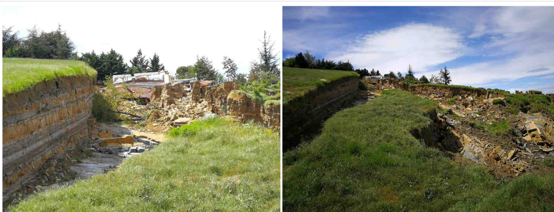
Figura 25. Frana a Borgo Tossignano (BO) (fonte: TV Vallata del Santerno).
