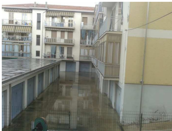
Figura 14. Foto di allagamento a Piacenza (fonte: www.liberta.it ).
