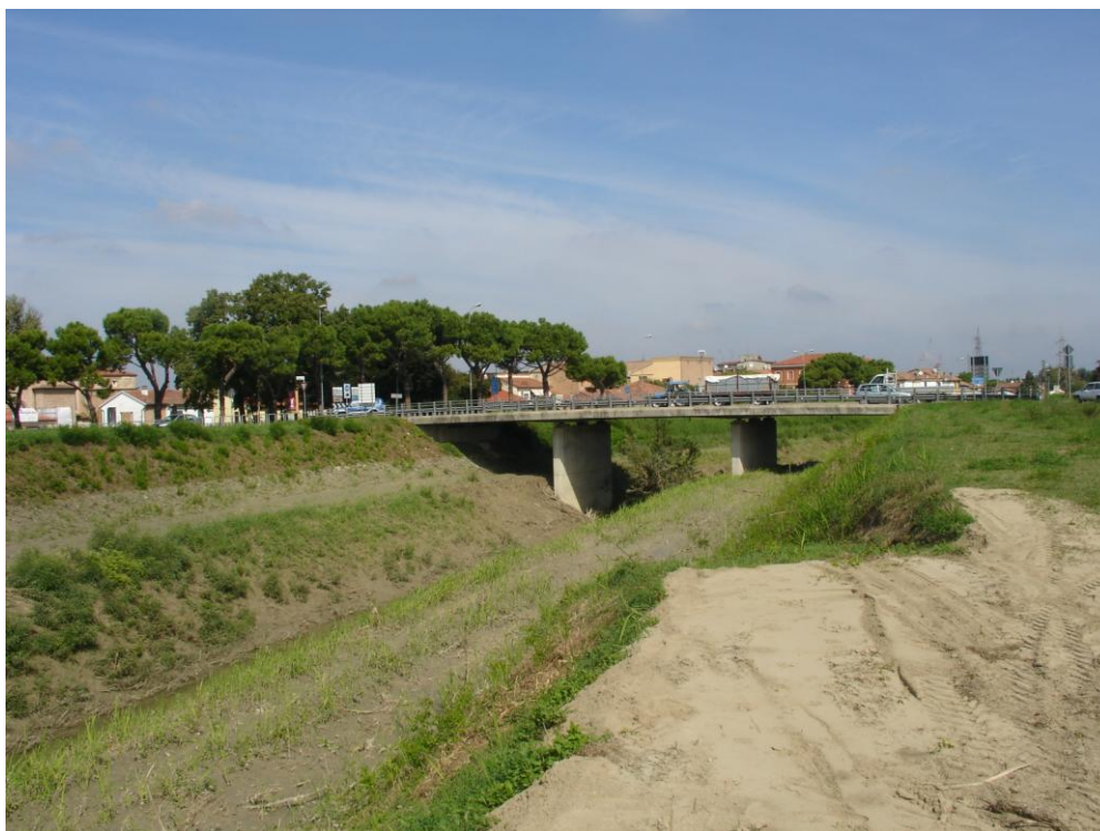
Foto 4: F. Senio (26/09/2014) – Ponte di Cotignola con evidente traccia della piena del 20 settembre in sponda sinistra.
