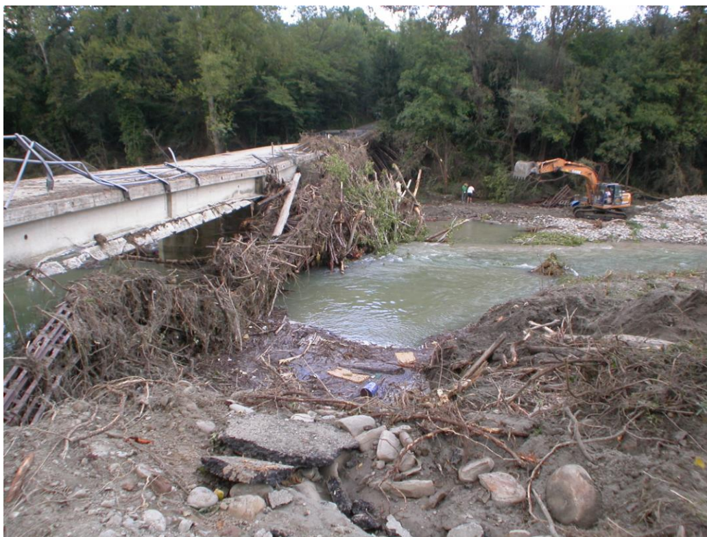
Foto 3: F. Santerno – Ponte di Carsegno (Via Macerato) poco a monte di Fontanelice
