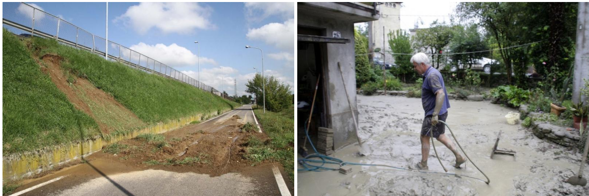
Figura 25: Immagini dello smottamento a Reggio-Emilia (a sinistra, fonte: Il Resto del Carlino) e degli allagamenti nel faentino (a destra, fonte: Il Resto del Carlino).
