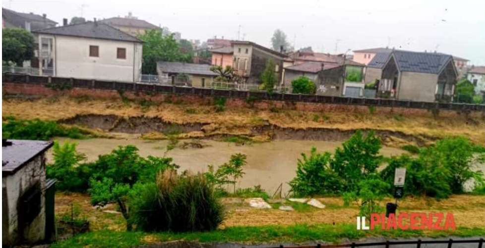
Figura 28: Erosione spondale lungo il Torrente Chiavenna a Caorso (PC), 16 maggio 2024, da Il Piacenza.
