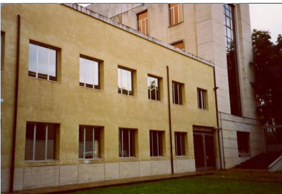
Ampliamento (1993) di scuola a Forlì
