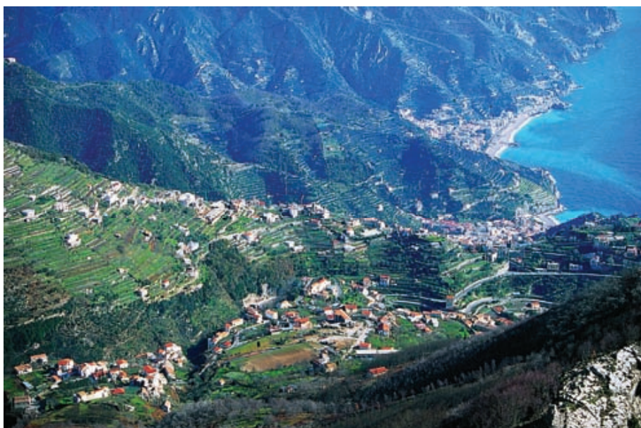
I sistemi di terramenti storici della Penisola Sorrentina-Amalfitana (Archivio Risorsa - Napoli)
