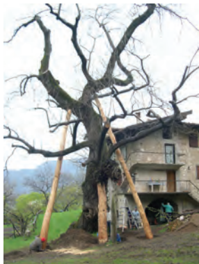
Fase di consolidamento del Maroner di Carobbi (A. Ricci)
