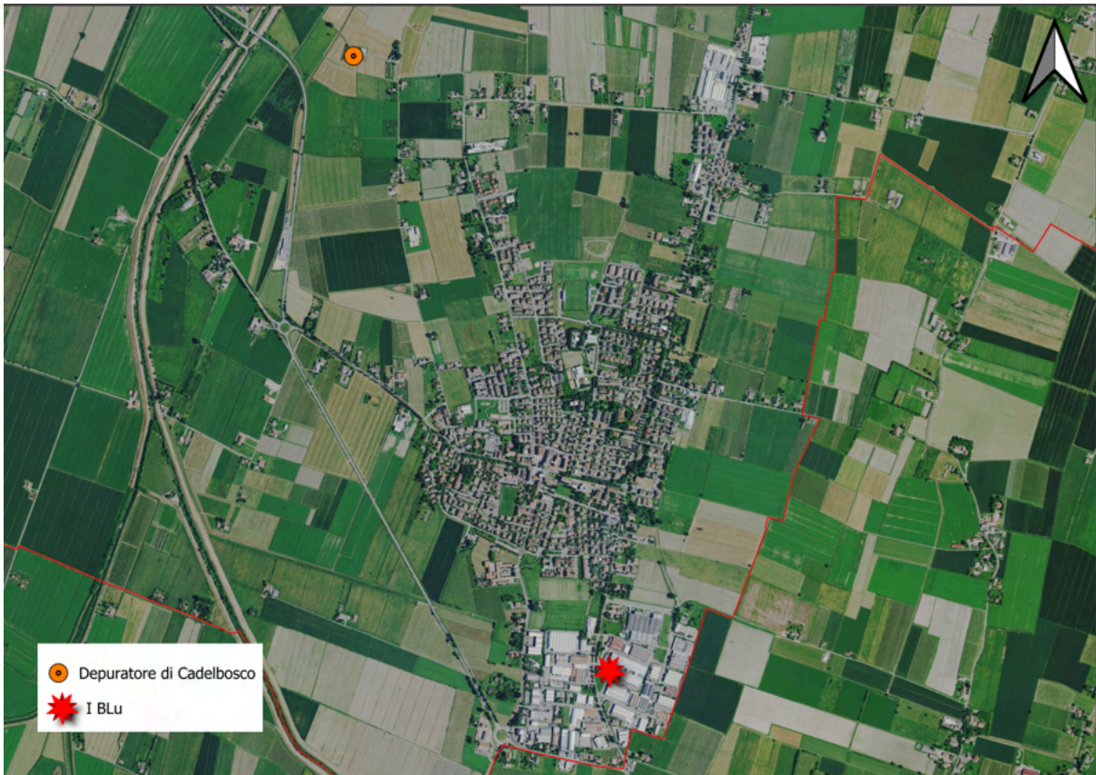
Depuratore di Cadelbosco
