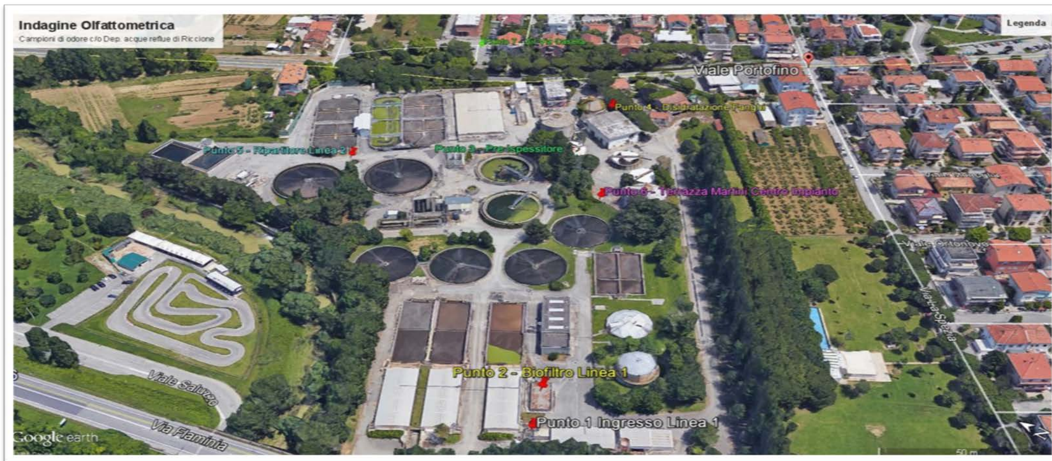
Figura n° 4: Vista delle sorgenti di odore campionate, della postazione in cui è stato collocato il sistema olfattivo elettronico (foto da Google Earth®)
