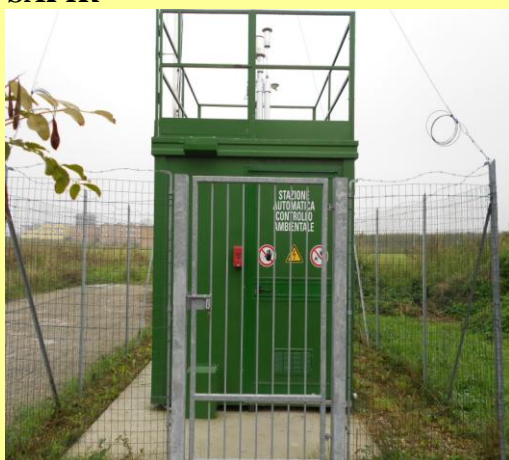
Stazione: Porto S. Vitale (Ravenna) ex SAPIR
