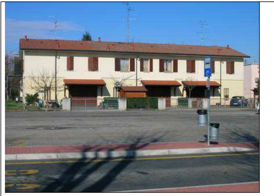
Figura 2 - Vista dalla fermata autobus delle abitazioni interessate dalla rilevazione
