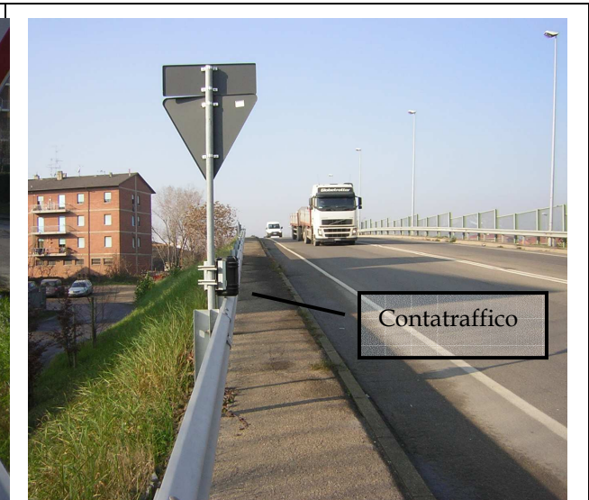
Figura 5 - Vista del cavalcavia dal punto di installazione del contatraffico (direzione verso Via Radici)
