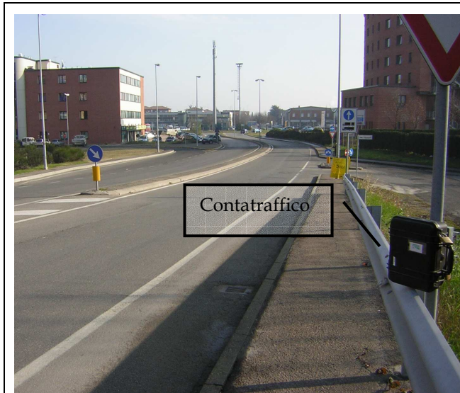
Figura 4 – Vista del cavalcavia dal punto di installazione del contatraffico (direzione verso Circonvallazione Nord-Est)
