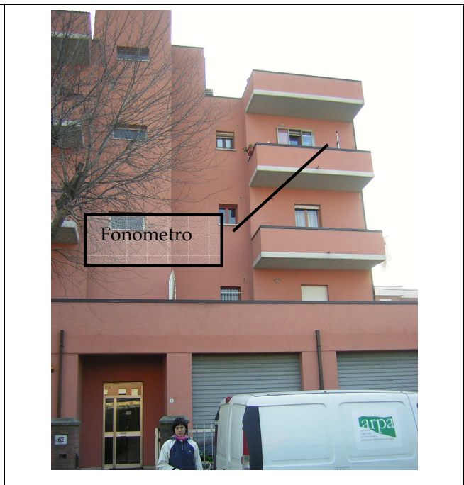
Figura 3 – Edificio civico n. 62 di Via San Gregorio
