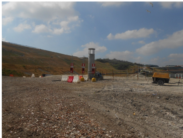
Vista della torcia mobile
