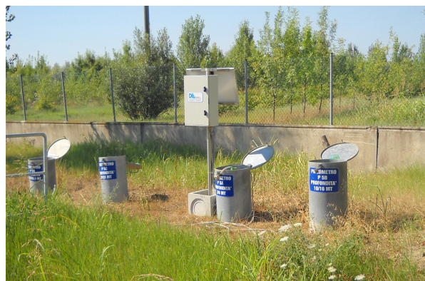
Vista dei piezometri P5A-P5B-P5C-P5D
