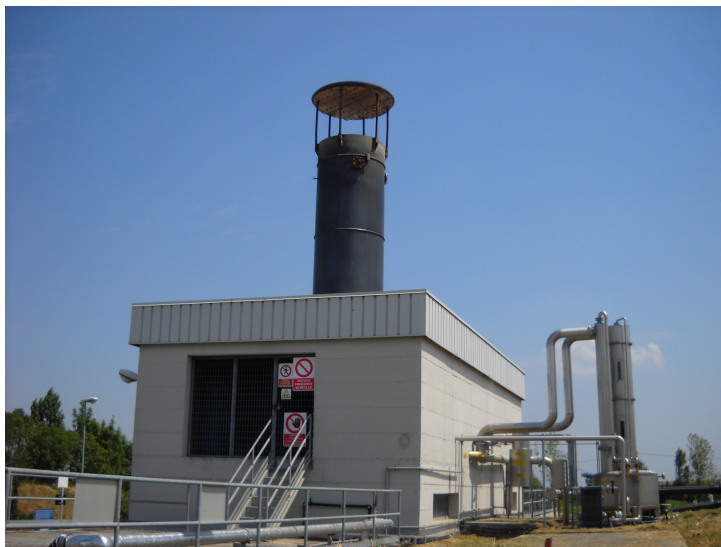
Vista della torcia di emergenza
