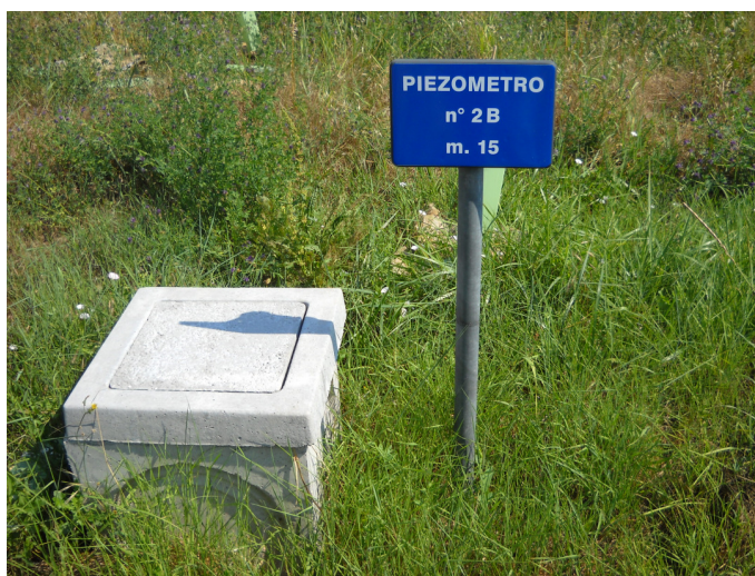
Vista di un piezometro della rete delle acque sotterranee
