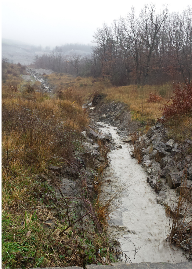
Vista del fosso di scolo F2 (punto 3)
