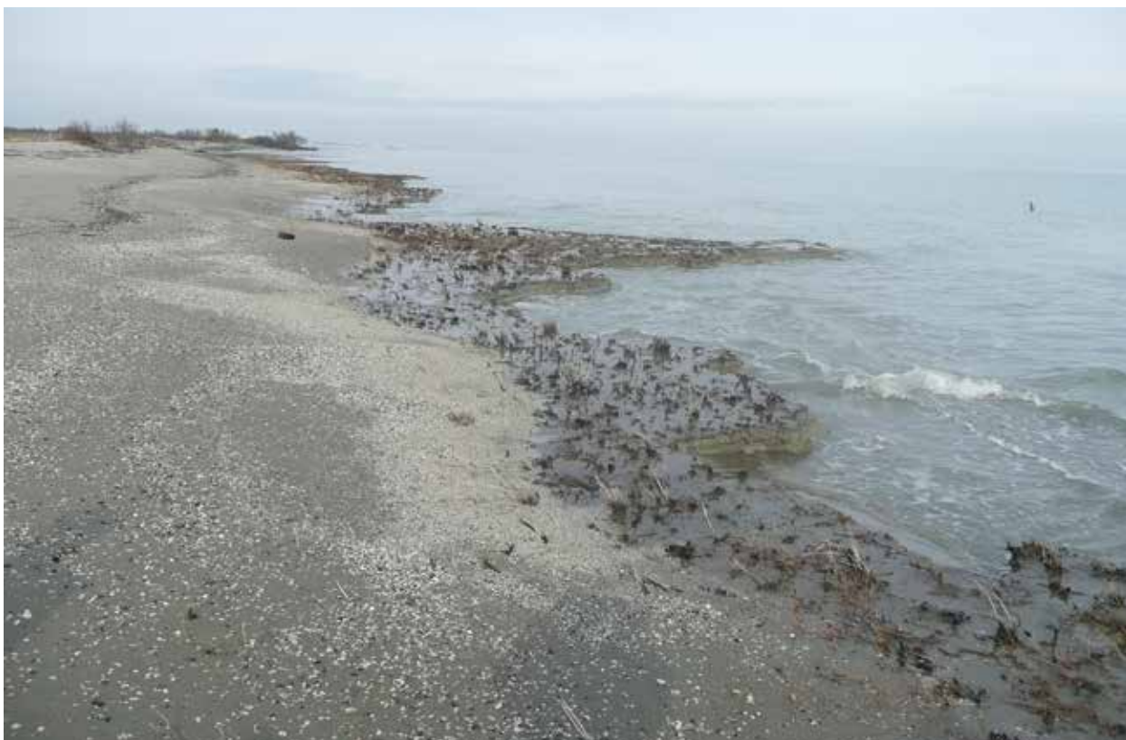
Figura 152 Argille lagunari affioranti nella zona intertidale nel tratto a nord e a sud dello sbocco del Gobbino (foto febbraio 2014).
