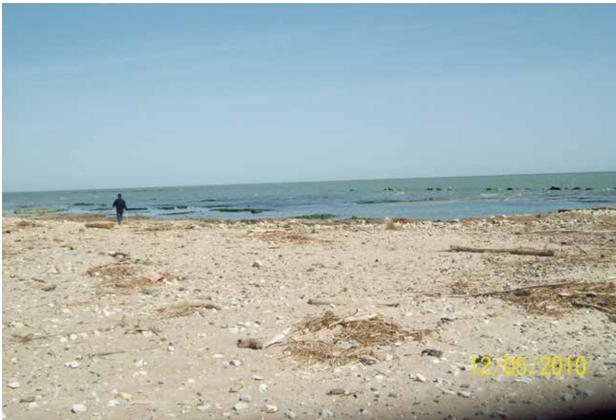
Figura 101 - La zona a nord del Poligono Militare dove il mare ha demolito 700 m di opere di difesa (12 Maggio 2010).
