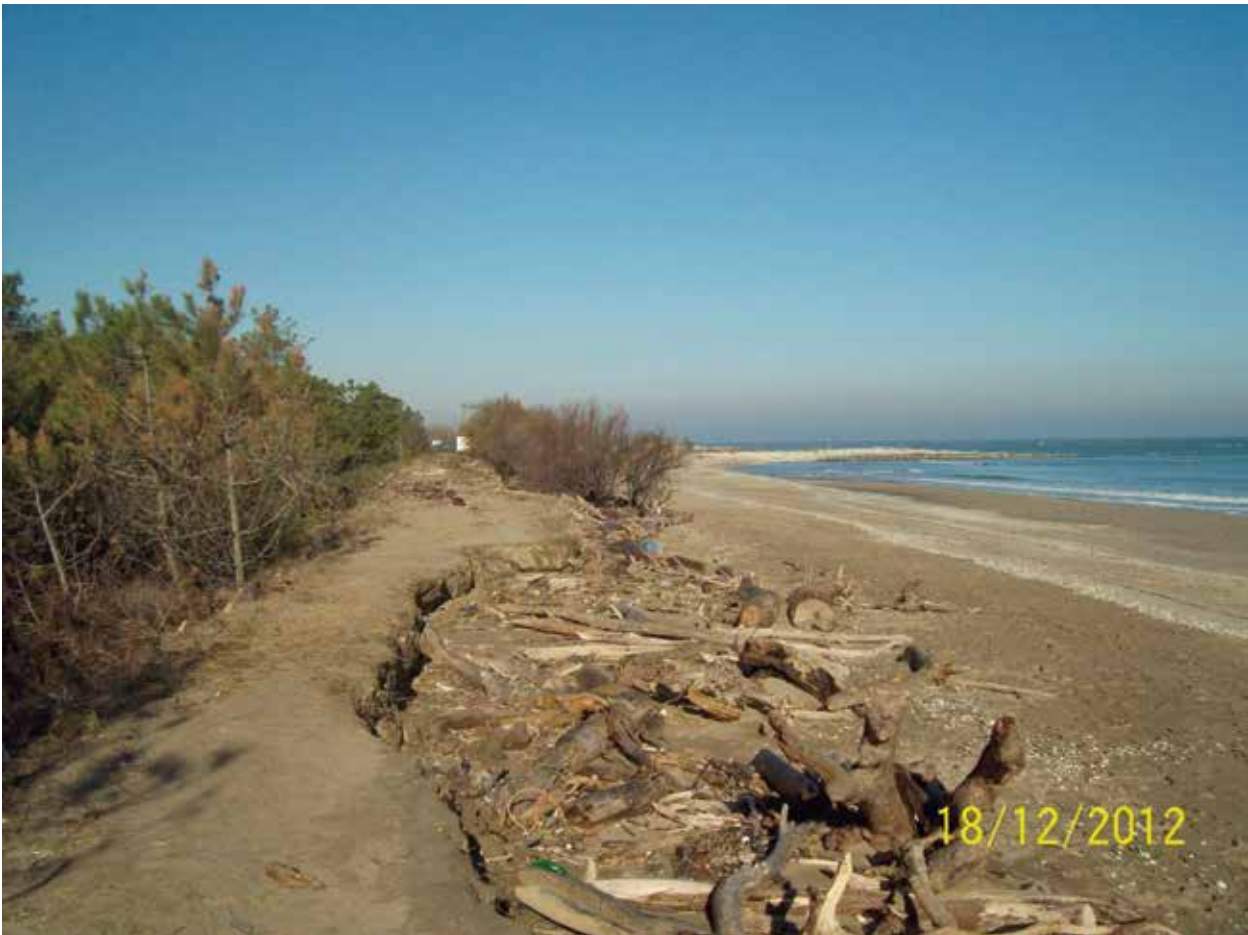
Figura 87 - Zona a sud del sistema di difesa di Lido di Dante: la duna è scomparsa e il terrapieno di difesa retrostante è stato seriamente compresso dalle mareggiate.
